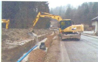
Gradnja kanalizacije v Tuhinjski dolini
